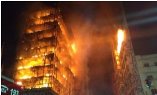
Figura 3: Incêndio de prédio em São Paulo
